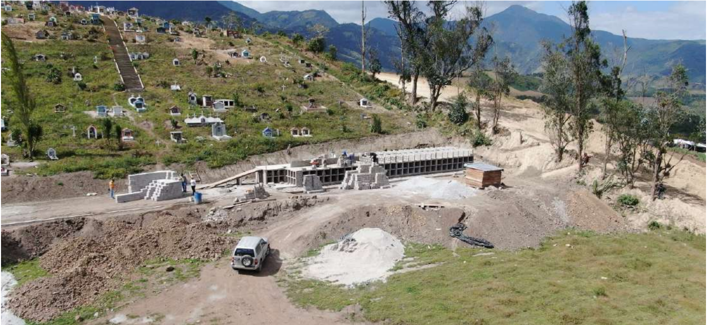
Para agosto 2023 se efectuó la donación de 100 quintales de cemento para la construcción de nichos en el cementerio de San José de Minas.
